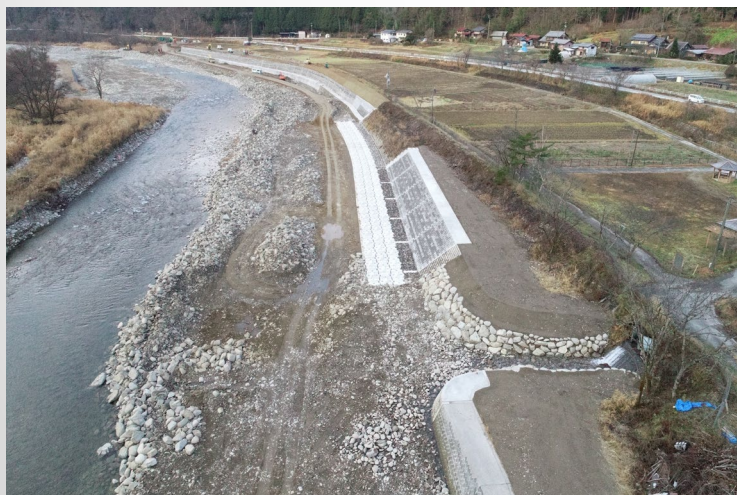
令和3年度 8月豪雨災害復旧工事
