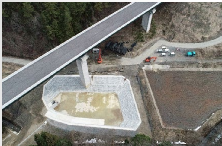
ICT施工 中部縦貫自動車道
