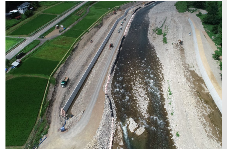
令和2年7月豪雨災害 災害復旧工事
